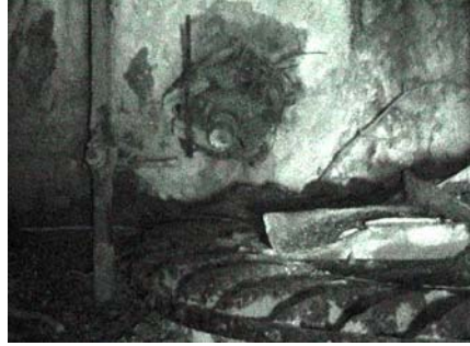
Şekil 15. Güney cephesinde suyun binadan tahliye edildiği tünel ve tünelin içinde yeralan ve yatay çarka su püskürten oluk
