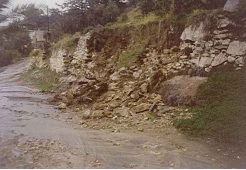
Foto 27. Lapta'da meydana gelen seyelanda tabaka halinde yüzeyi, kaplayan su ve seyelanın neden olduğu kütle hareketleri izlenebilmektedir.
