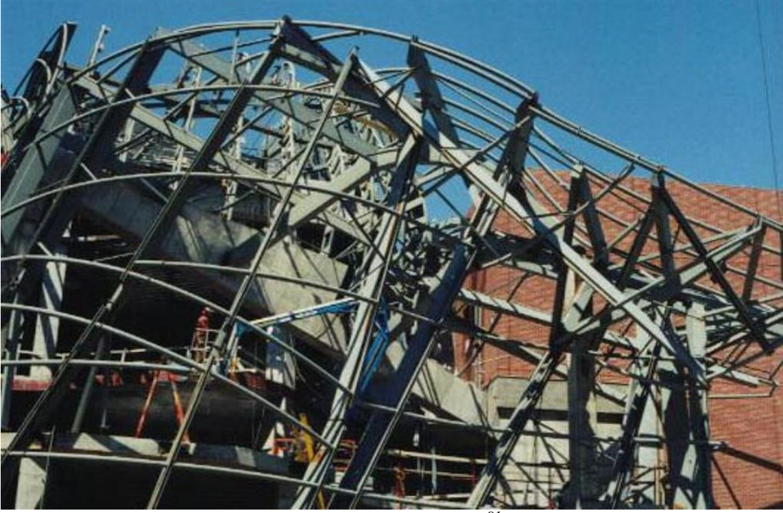
Resim 14. Guggenheim Müzesi, cephe konstrüksiyonu. 91
