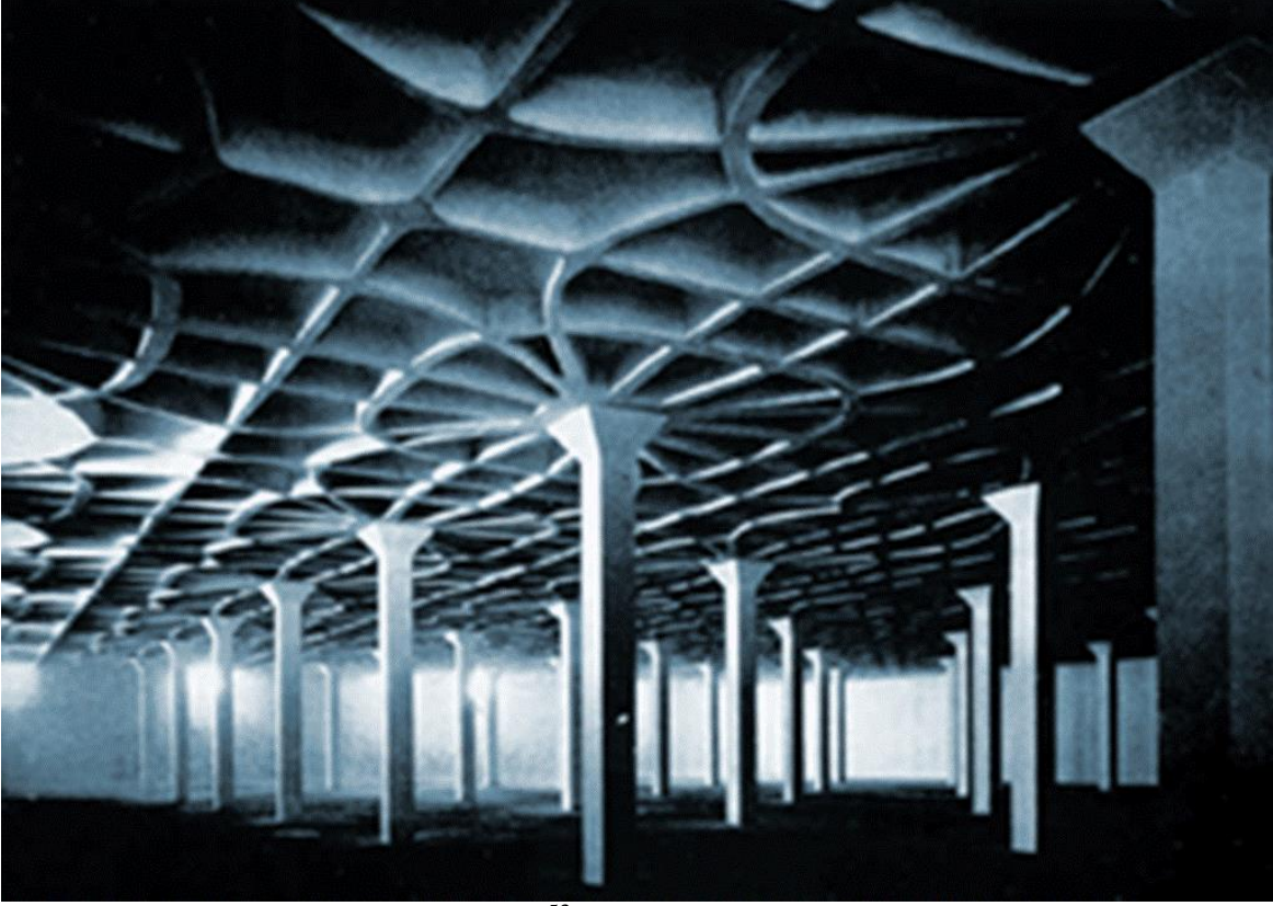
Resim 1. Nervî'nin nervürlü döşemesi. 53
