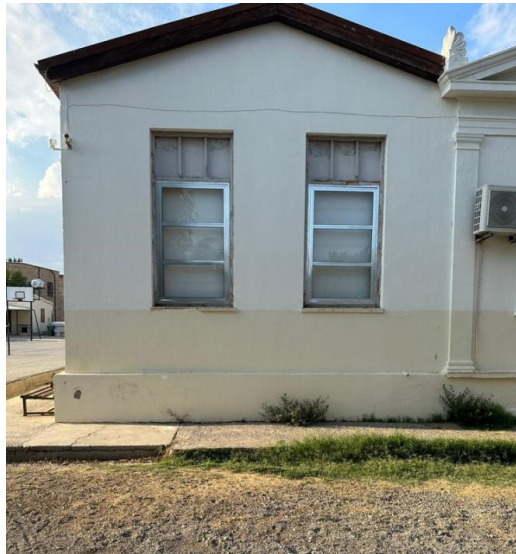
Şekil 147: Güneydoğu Cephesi Pencereleeri
