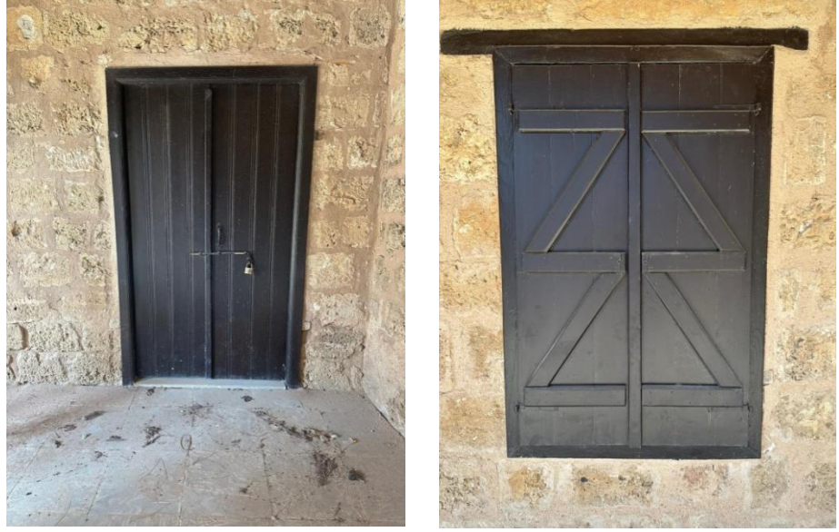
Şekil 74: Kuzey Birim Ahşap Kapı Ve Pencereler
