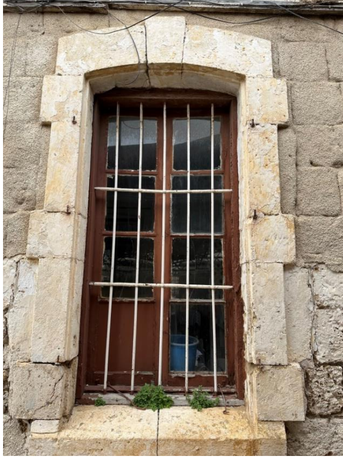
Şekil 103: Pencere Etrafındaki Taş Sövele
