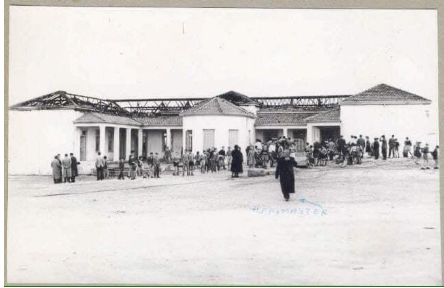
Şekil 135: II. Dünya Savaşı Dönemi Hava Saldırısı Sonucu Oluşan Hasarlar
