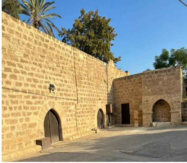
Şekil 72: Şömineli Ev Kuzey Giriş Cephesi
