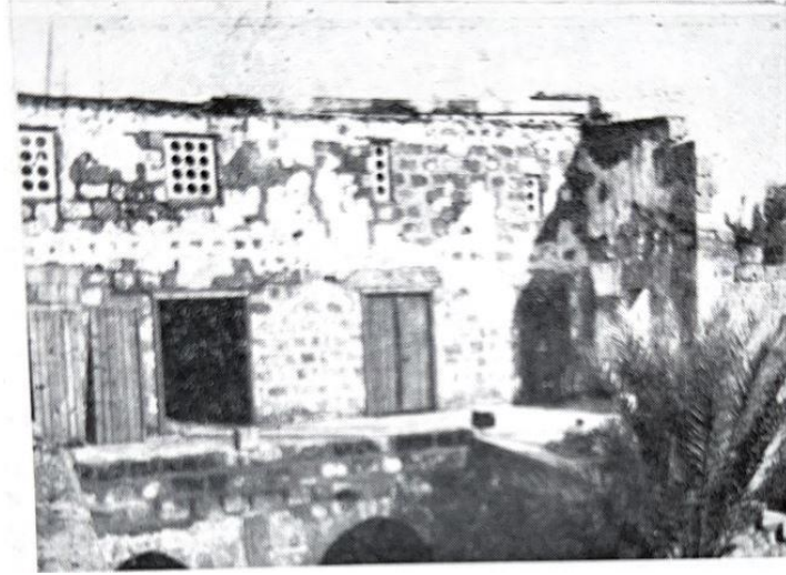
Şekil 194: Kuzey Birimde Yeniden Yapılan Çatı
