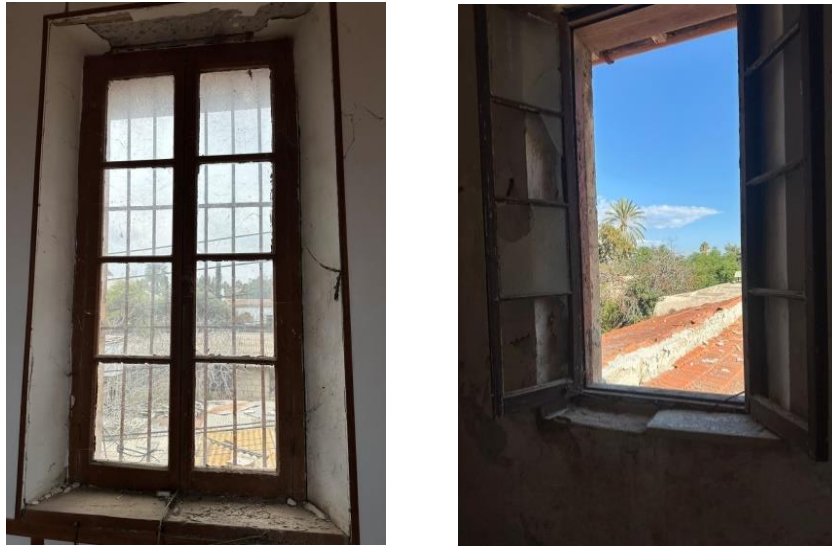
Şekil 125: Ahşap Pencere ve Mermer Denizlik
