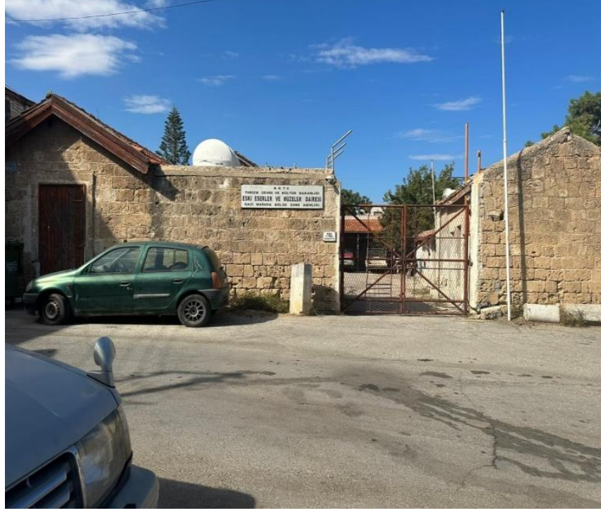
Şekil 99: Güney Cephesindeki Demir Kapı
