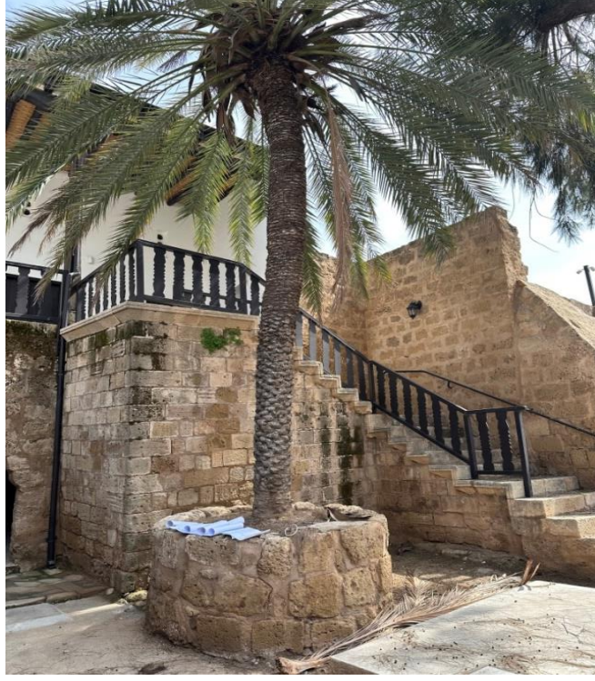
Şekil 39: Batı Duvarına Konumlanmış Üst Kat Merdiveni
