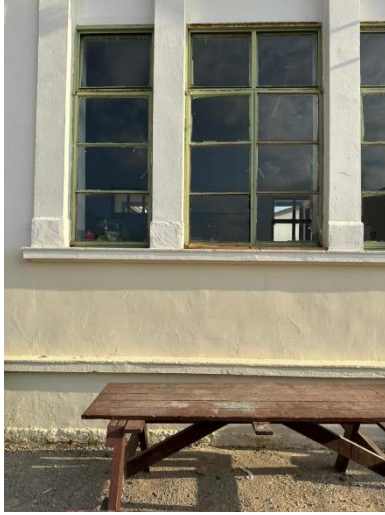
Şekil 166: Z/06 Sınıfı Demir Pencere ve Taş Denizlik
