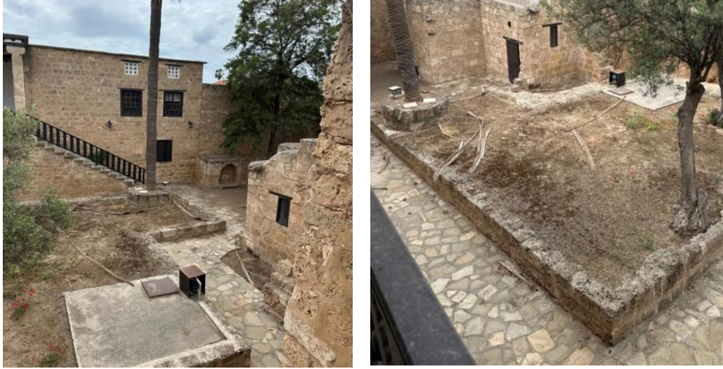
Şekil 50: Güney Avlusu Genel Görünüş
