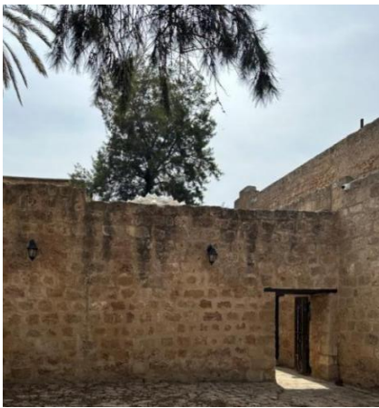
Şekil 174: Taş Duvarlar Üzerinde Yosunlanma ve Renk Değişimi
