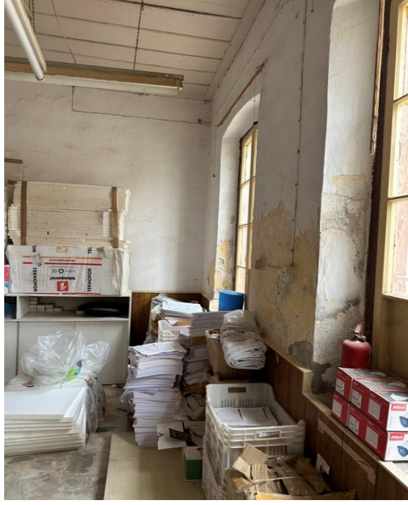
Şekil 101: Batı Cephesi Z/05 Odası
