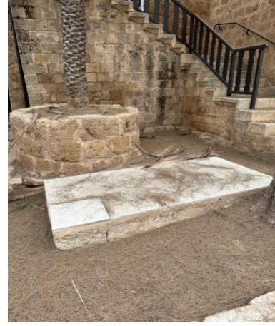
Şekil 32: Avlu içerisindeki Rogar ve Septik Tank
