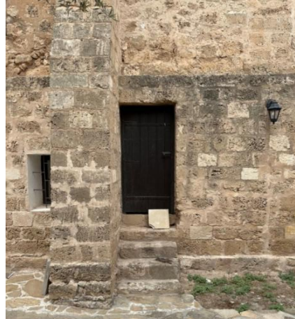
Şekil 174: Taş Duvarlar Üzerinde Yosunlanma ve Renk Değişimi
