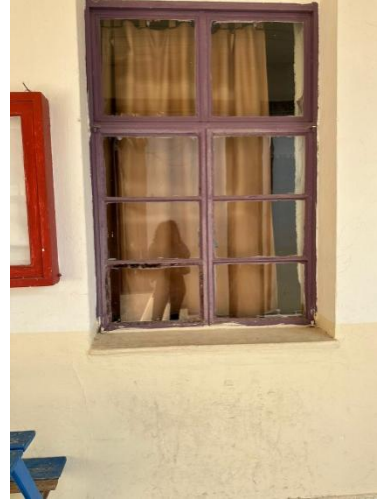
Şekil 166: Z/06 Sınıfı Demir Pencere ve Taş Denizlik
