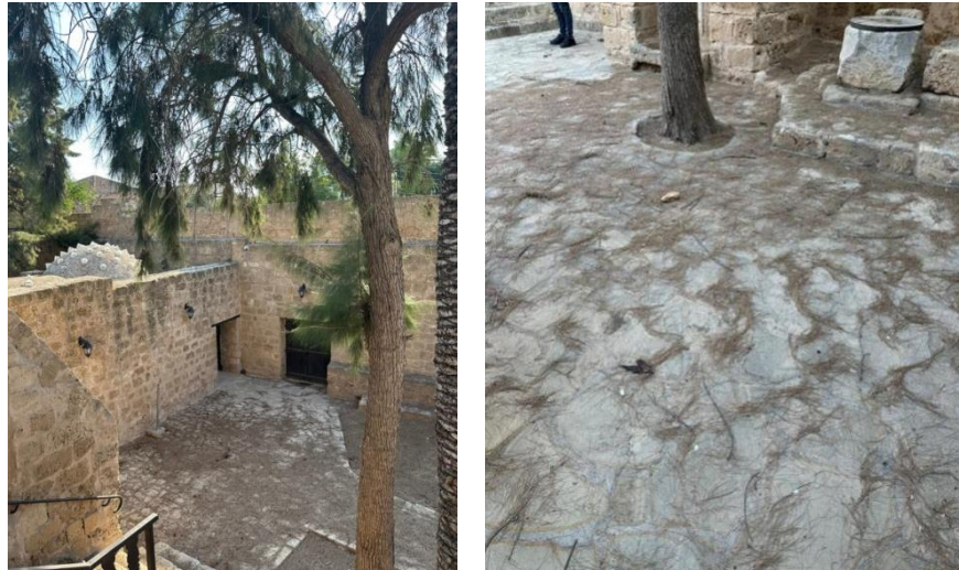
Şekil 73: Avlular Gönyeli Taşı Döşemeleri
