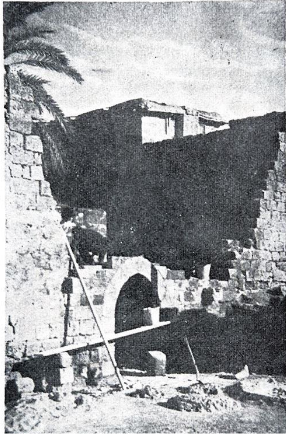
Şekil 192: Batı Cephesinde Yıkılıp Yeniden Yapılan Duvar (Report 1949 S:18)
