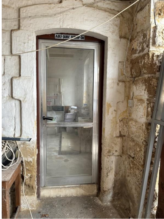
Şekil 102: Kapı Etrafındaki Taş Söveler
