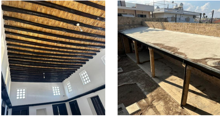
Şekil 83: Ahşap Mertek Üzeri Hasırlar
