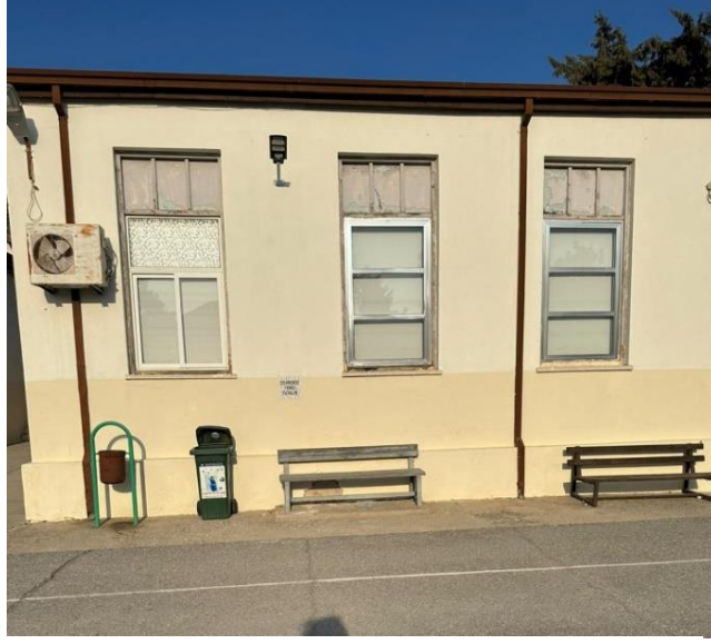
Şekil 148: Güneybatı Cephesi Pencereleeri
