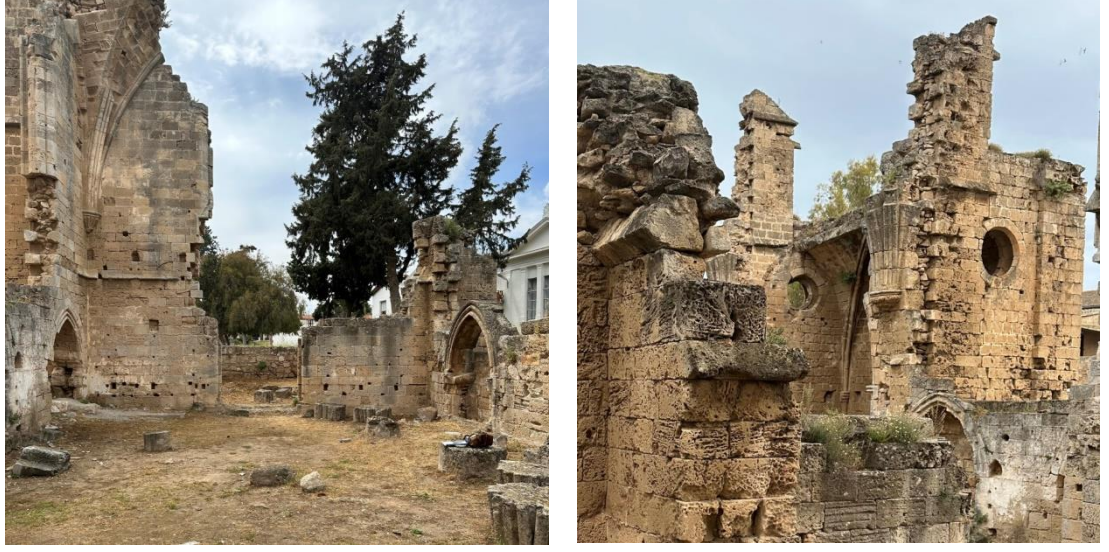
Şekil 19: Doğu Cephesi ve Güney Şapeli Pencereler
