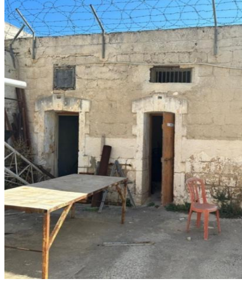
Şekil 118: Betonarme Zemin ve Tepe Pencereleeri ile Taş Söveler
