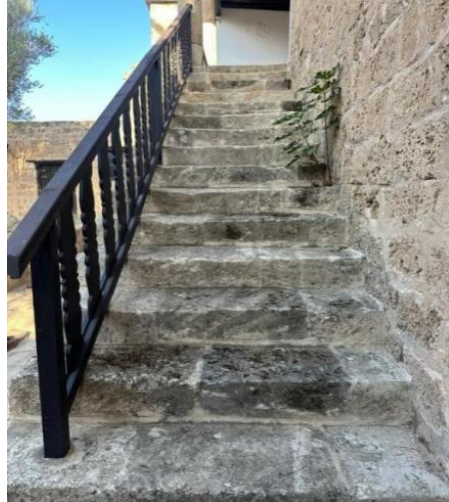
Şekil 80: Güney Birim Merdiven Korkulukları
