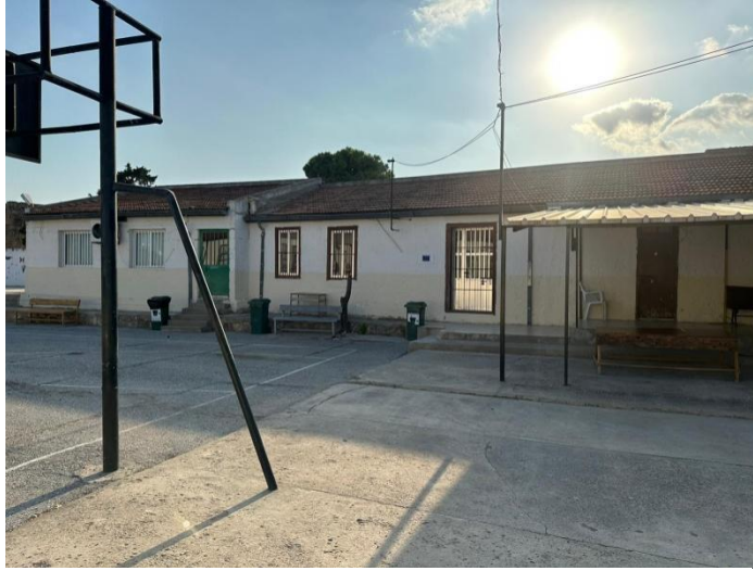
Şekil 153: B Binası Depo ve Hademe Odası
