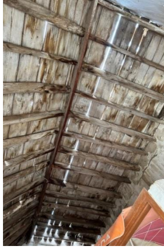
Şekil 128: Z/27-Z/28-Z/29-Z/30 Odaları Kirişler, Kaplama Levhası ve Kiremit
