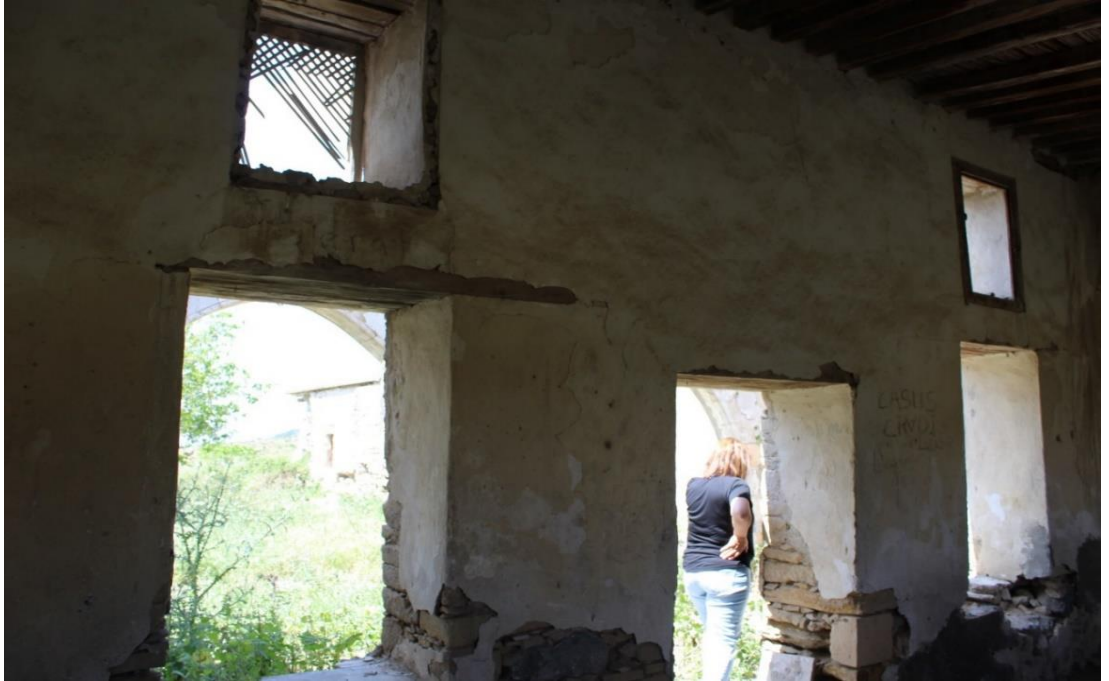
Şekil 47 Panagia Katharon Manastırı Kapı ve Pencere (Soykök, 2023)
