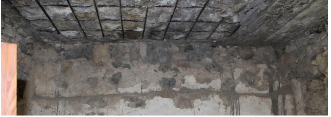
Şekil 62: Mahsen Betonarme Plaka (Soykök, 2023)
