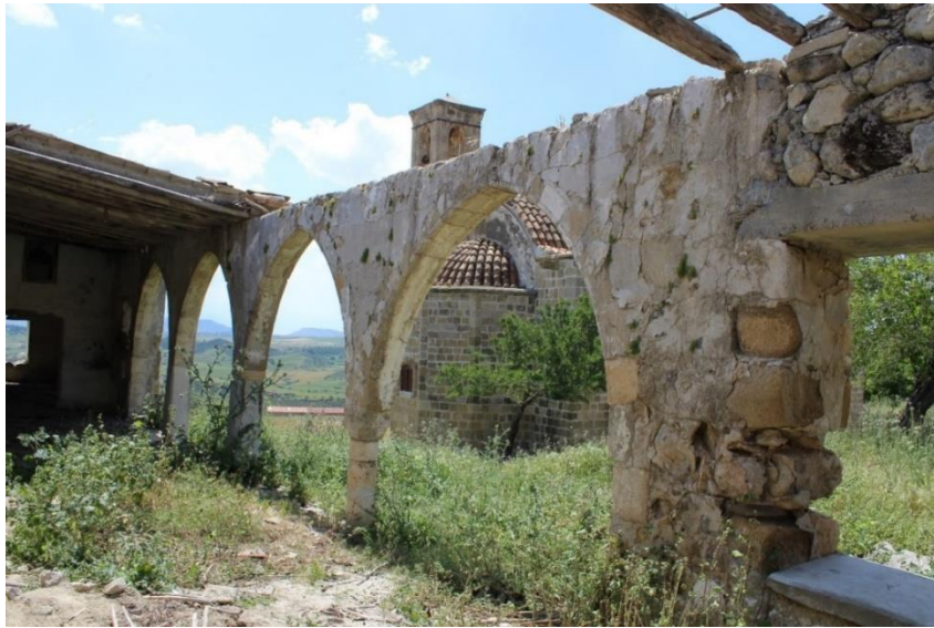
Şekil 58: Yığma Taş Kemerler (Soykök, 2023)
