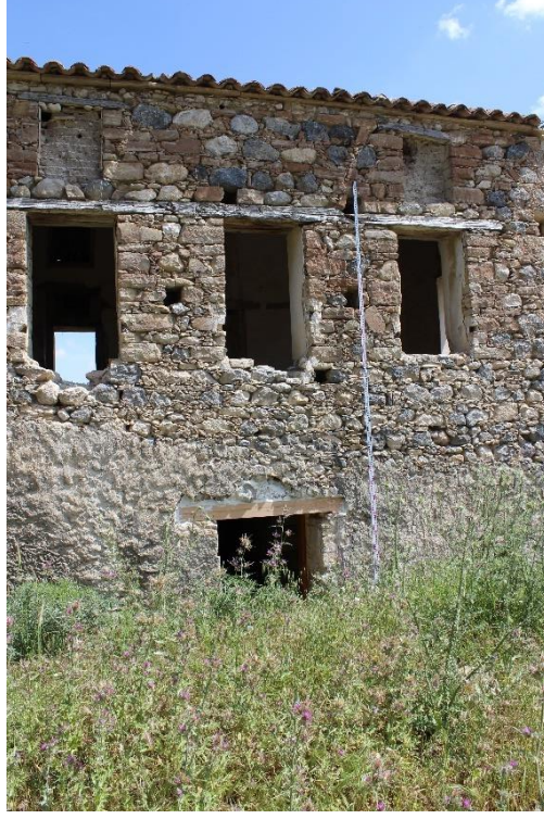
Şekil 76: Derz Boşalması (Soykök, 2023)
