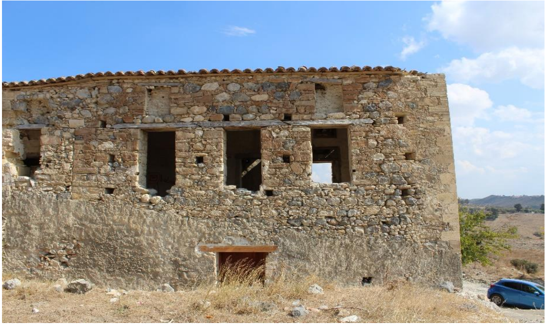
Şekil 53: Panagia Katharon Manastırı Güney Cephesi (Soykök, 2023)
