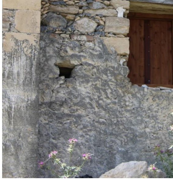
Şekil 65: Çimento içerikli sıva (Soykök, 2023)
