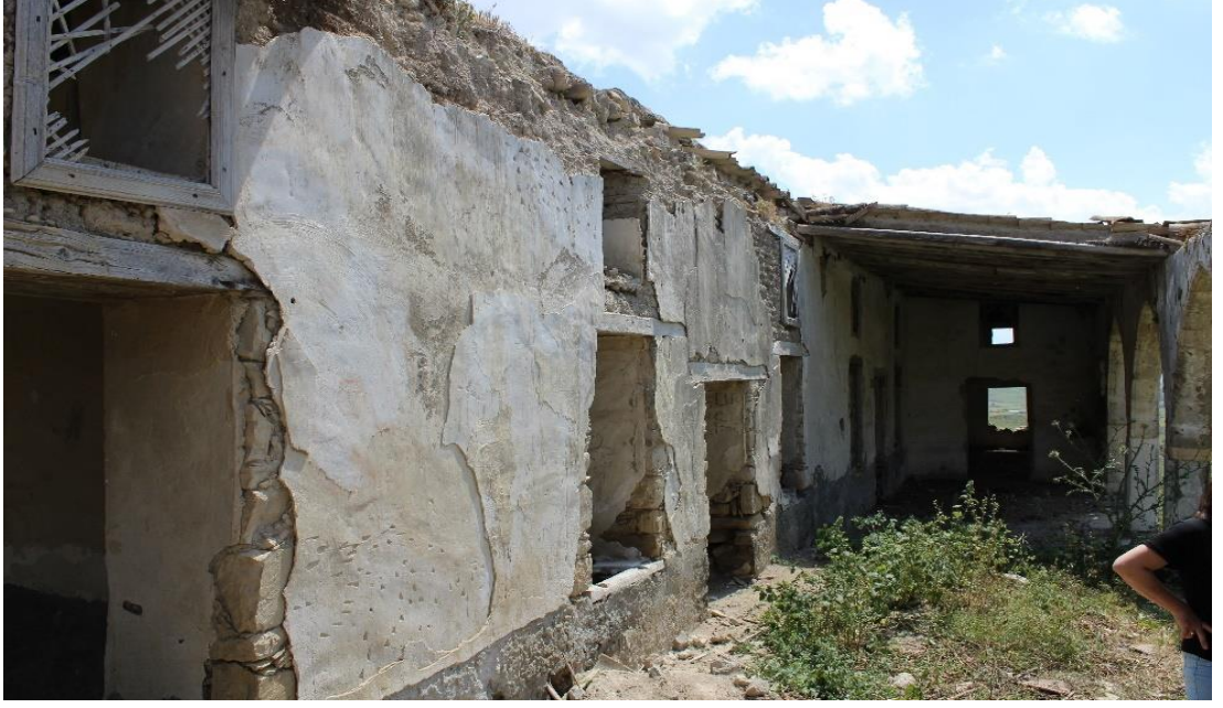
Şekil 57: Yığma Taş ve Kerpiç duvar (Soykök, 2023)
