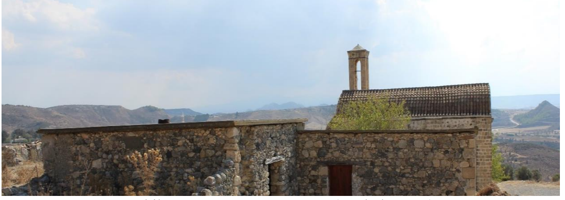
Şekil 61: Z8-9 Betonarme Çatı (Soykök, 2023)
