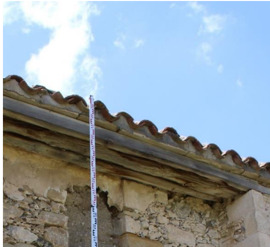
Şekil 60: Yapı Çatı Malzemesi Kiremit (Soykök, 2023)
