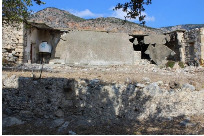
Şekil 59: Niteliksiz ek Betonarme Çatı (Soykök, 2023)
