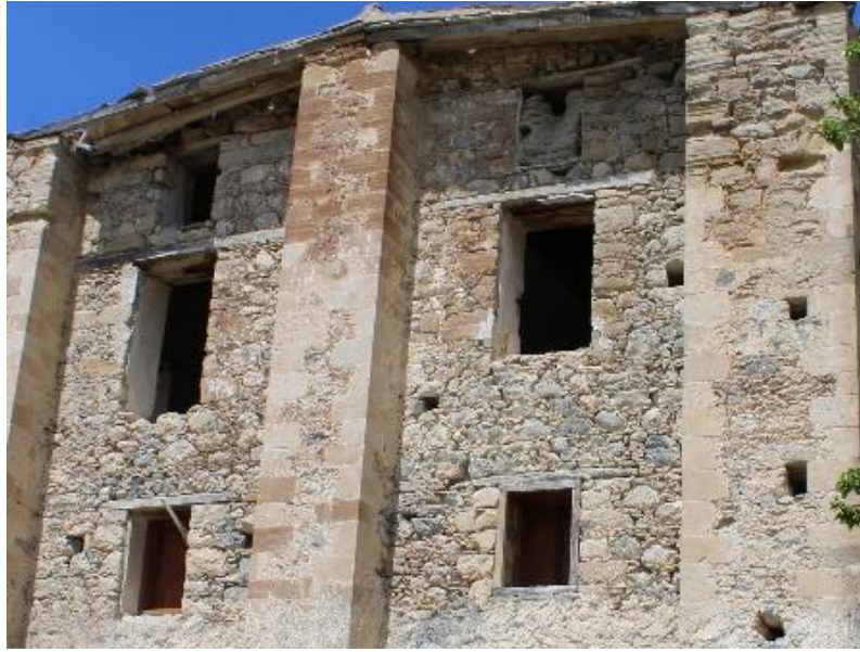
Şekil 56: Yığma Taş Malzemesi (Soykök, 2023)
