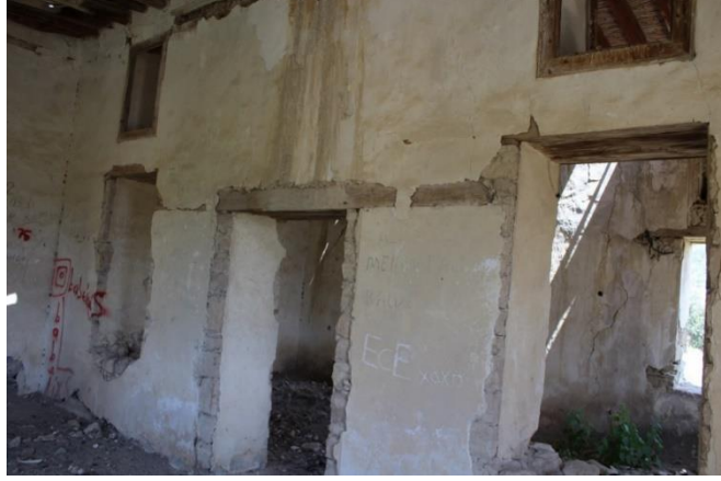
Şekil 41: Panagia Katharon Manastırı Z01A-B ayıran duvar (Soykök, 2023)
