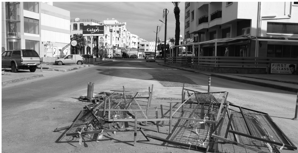
Gazimağusa'nın Gülseren bölgesinde yapılan alt yapı çalışmaları üç aydan fazla süredir devam ediyor.
