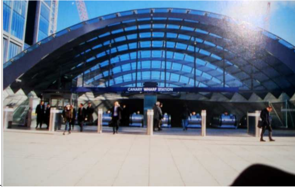
Figure 3.5: Canary Wharf metro station, London (Ernest Von Mejenfeldt. 2004)
