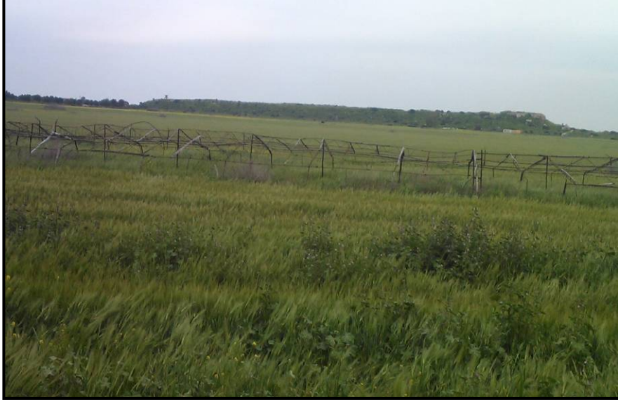
Foto 4: Ahşap ve metal konstrüksiyon malzemelerinin bir arada kullanıldığı yay çatılı plastik örtülü yapılara bir örnek (Yeşilirmak / Lefke).
