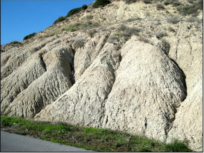
Foto1: Kuruova - Avtepe arasında bulunan yol kenarındaki oyuntu erozyonu.
