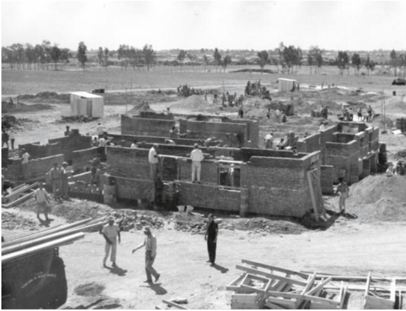
Mücahitlerin Göçmenleri İnşaatında Çalışmaları
