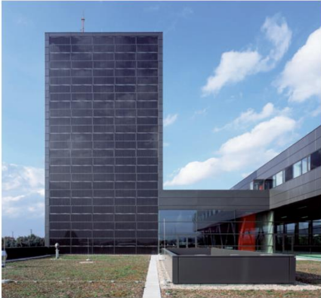
Figure 3.9. 41 Active energy façade (Kulka, 2007)
