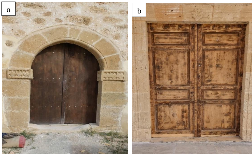
Figure 2.53: a) New door 1 b) New door 2
