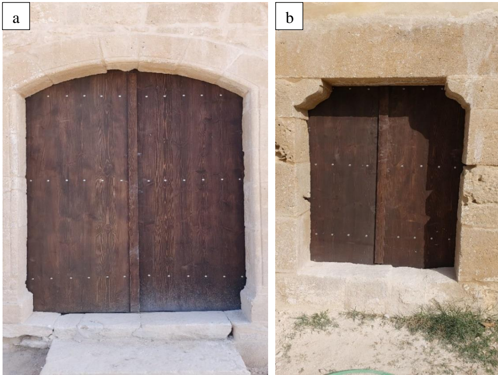
Figure 2.54: a) New door 3 b) New door 4
