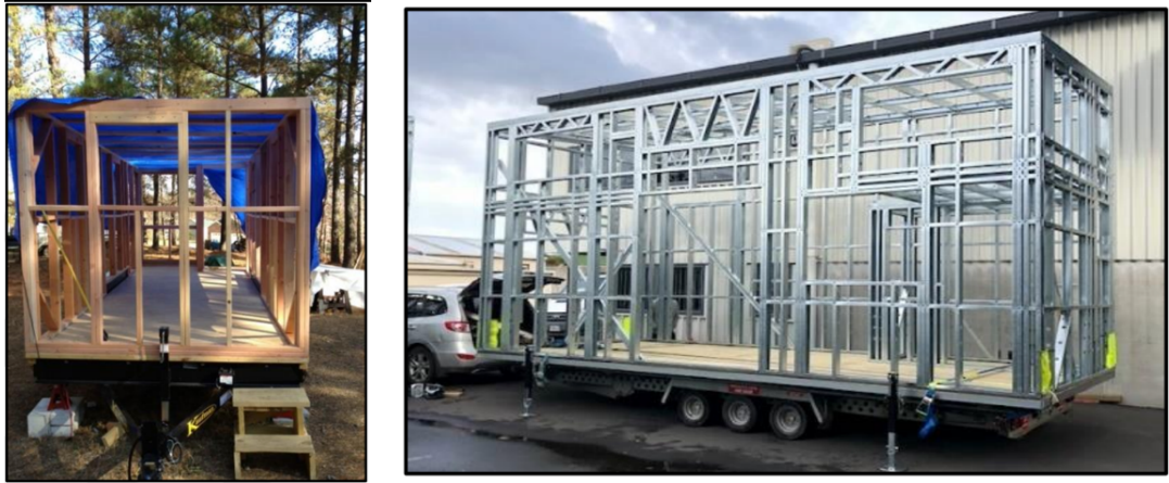
Şekil 3.9: Mikro Konutlarda Ahşap ve Çelik Strüktür Örneği (Kaynak: https://tiny-project.com/advanced-framing-for-tiny-houses/ )
